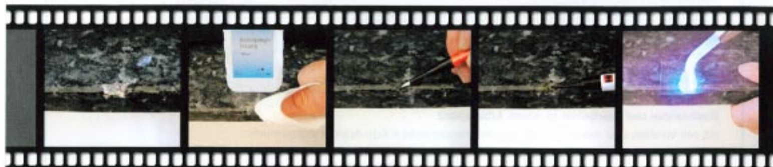
Kantenschaden an einer polierten Natursteinplatte.
