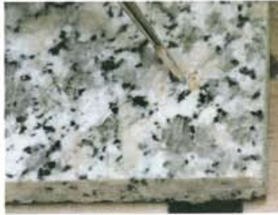
... mit einem feinen Pinsel der Struktur entsprechend aufgetupft...
