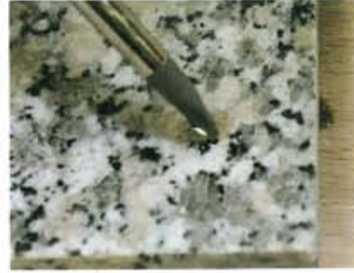
... und dann mit dem transparenten UV-Füller die fehlende Substanz aufgefüllt.
