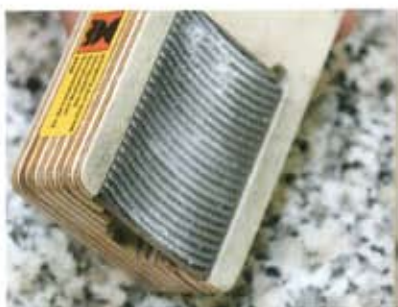
Nach dem Aushärten mittels UV-Lampe wird der geringfügige Überstand an Füller oberflächeneben abgezogen...
