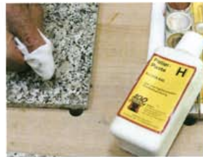
... und der Übergang mit der Polierpaste auspoliert, bis der gewünschte Glanzgrad erreicht ist.
