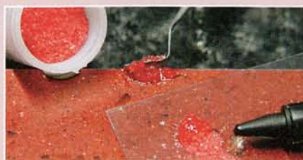
Beispiel einer Schadensbehebung mit farblich eingestellten Granulaten
